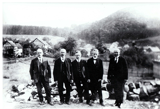
Grundsteinlegung an der neuen Kapelle.
